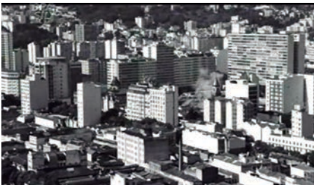
Figura 15 – Edifício em meio ao ambiente urbano (Transeunte 2010)
