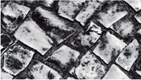
Figura 14 – Ambiente Urbano Calçada à Portuguesa (Transeunte 2010)
