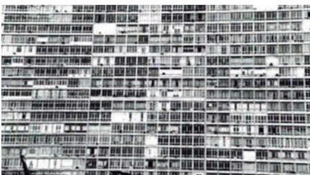
Figura 16 – Esquadrias Edifício (Transeunte 2010)
